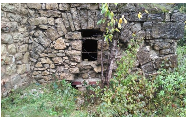
Façade nord avant
